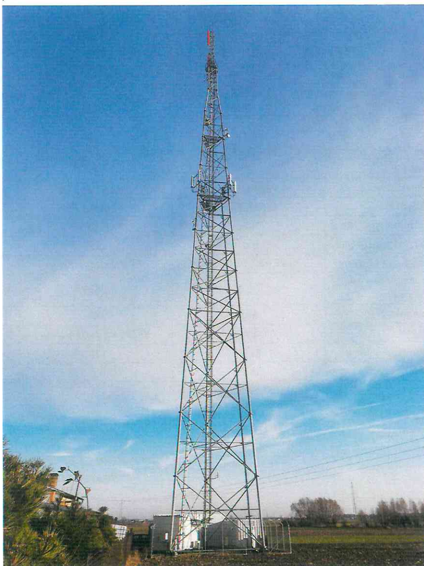
Zdjęcie 1 Badany obiekt
