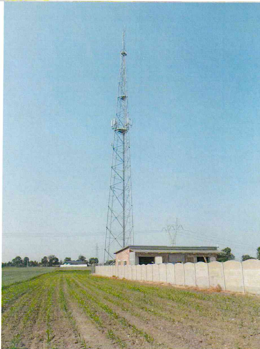
Fot. 1. TON Sieciechów – widok obiektu
